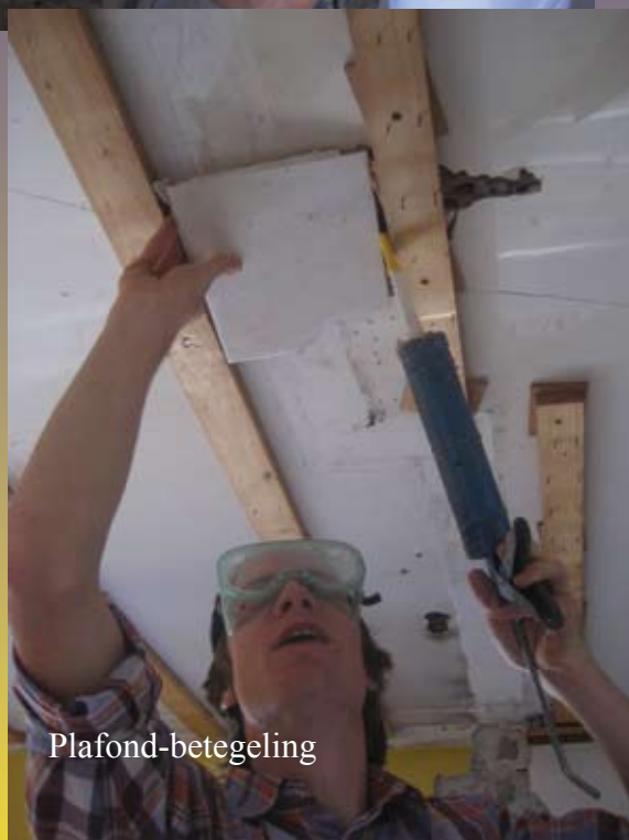
Vakkundig verwijderen van oude tegellaag
